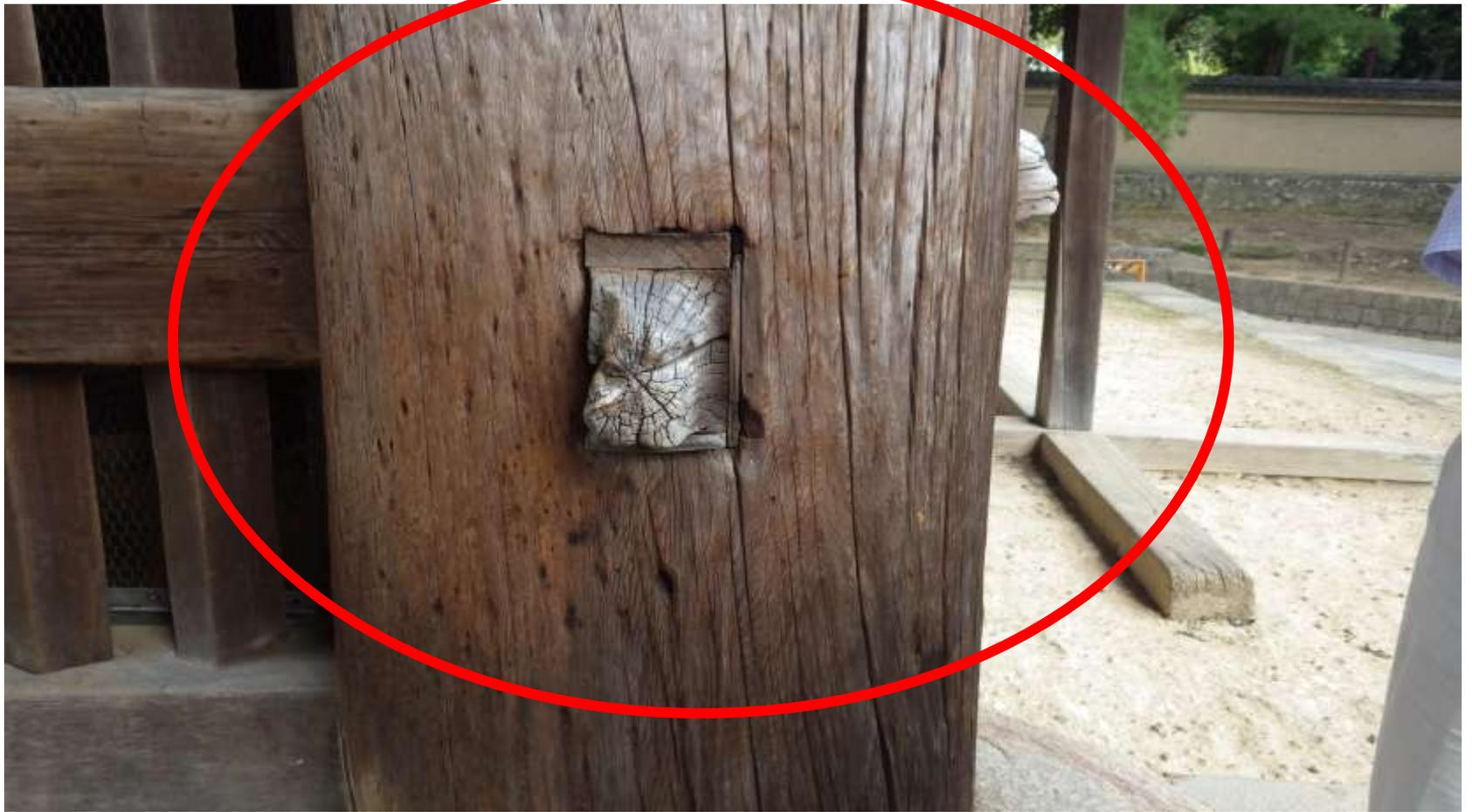
柱の内部で、2本の木材が組み合わされている
